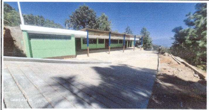
Foto 2: Pintura en muros exteriores e interiores
