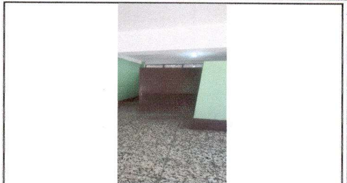
Foto 8: Mantenimiento a estructura (Lijado, cambio de tubo, cepillado, sujeciones, aplicación de pintura)
