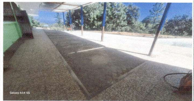
Foto 4: Reparación de planchas de concreto de patio
