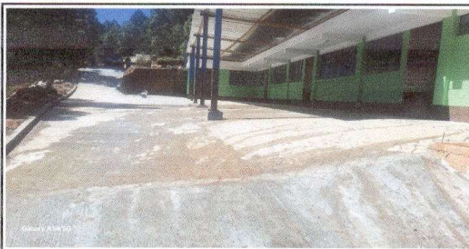
Foto 5: Reparación de planchas de concreto de patio
