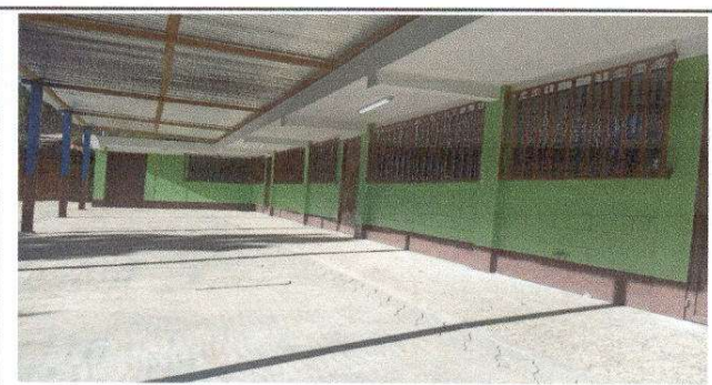
Foto 6: Fabricación e instalación de balcones de metal en ventanas
